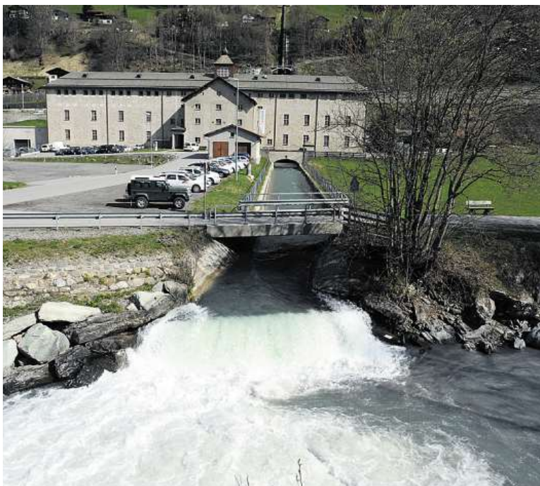
Dank dem Kraftwerk Chlus soll das in Küblis turbinierete Wasser künftig über einen Druckstollen nach Trimmis geführt werden. (FOTO THEO GSTÖHL)
